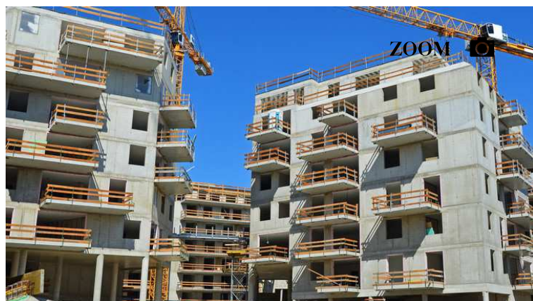
Immeubles en chantier / photo 5000 - Fotolia
